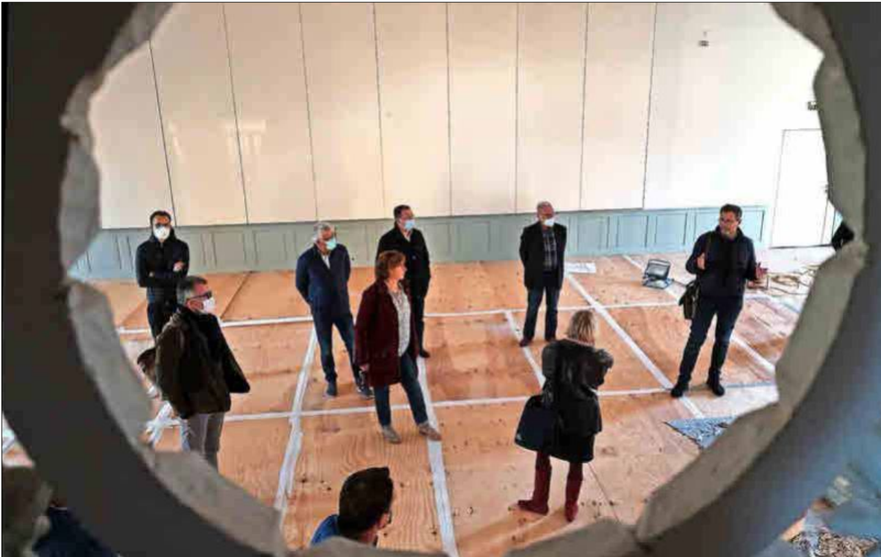
Vor dem geschlossenen Bühnenhaus erklärt der städtische Bauprojektleiter Thomas Binkert (rechts) das Umbauvorhaben im eigentlichen Salmensaal.
