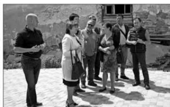
Die deutsche Delegation mit Dolmetscherin vor dem Rotkreuz-Gebäude, das sichtlich der Ausbesserung bedarf.
