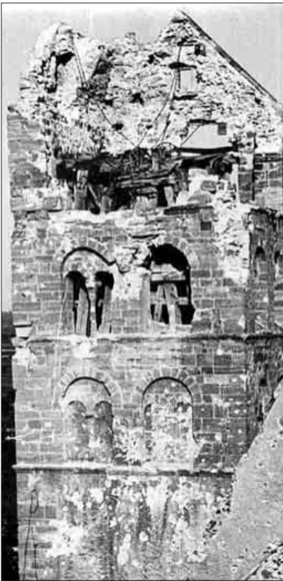
Auch das Münster wies große Schäden auf.
