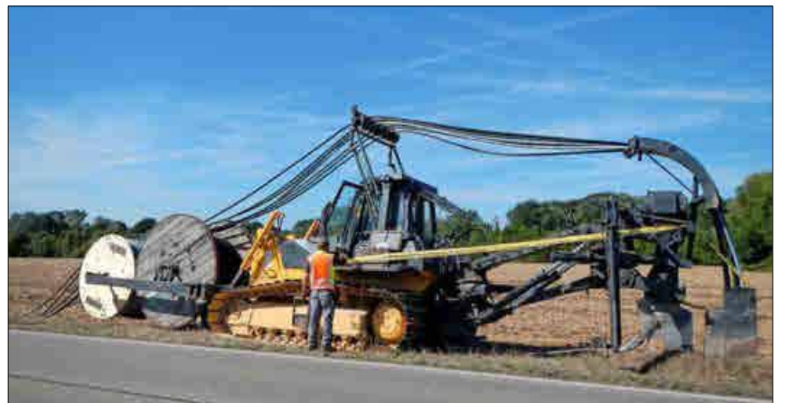
Mit dem Kabelpflug können die Stromkabel schnell und bodenschonend verlegt werden.
