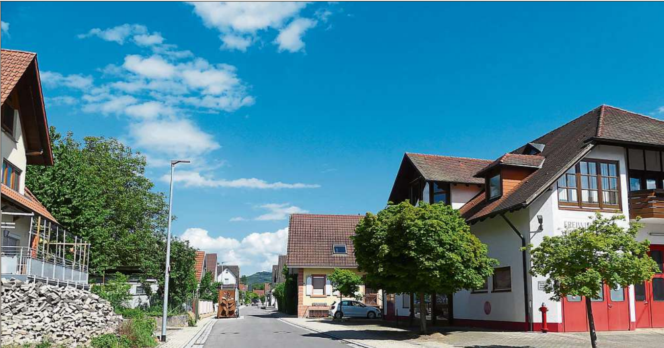
In der Meiersmattstraße in Oberschopfheim stehen erneut Arbeiten an, der Kanal wird unterirdisch saniert.
