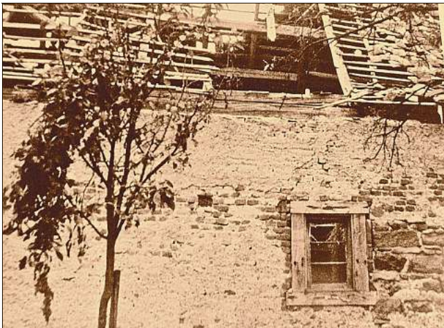
Gegen Ende des Zweiten Weltkriegs vor 75 Jahren wurden in Ottenheim viele Gebäude zerstört.
